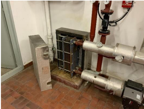
Figure 8 : Échangeur sous-station Nord
