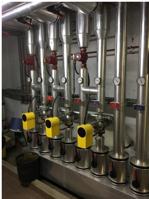
Figure 6 : Pompes et vannes 3 voies secteur Dalcroze
