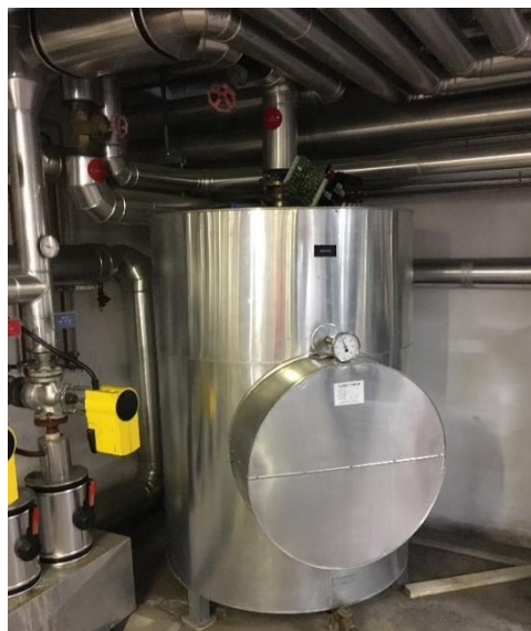
Figure 7 : Chauffe-eau de 1'000 litres
