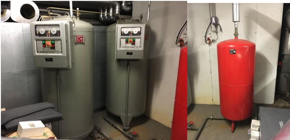
Figure 4 : Vases d'expansion du réseau hydraulique primaire
