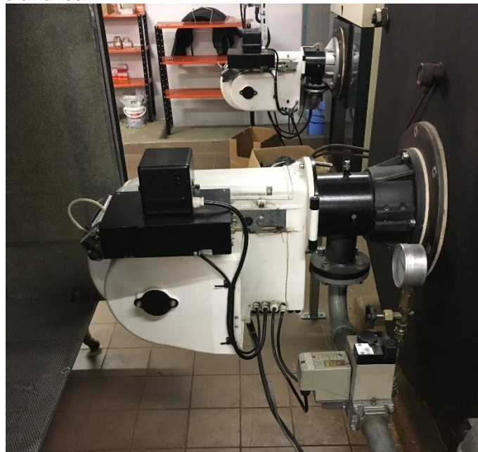
Figure 3 : Brûleurs des chaudières n°1 et n°3
