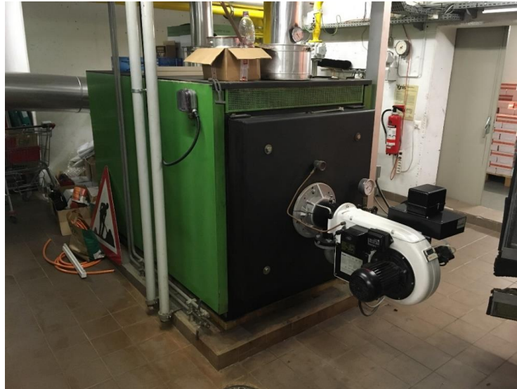
Figure 2 : Chaudière n°2, brûleur gaz
